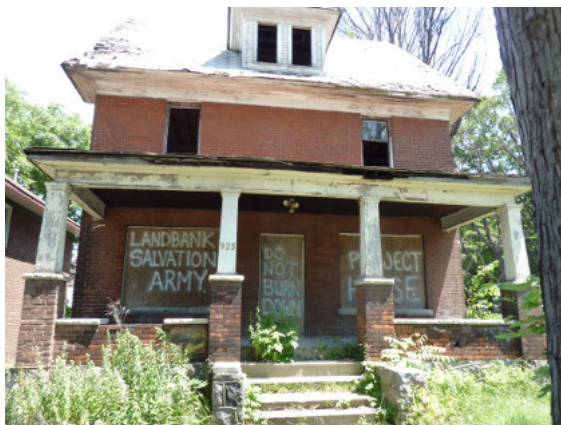
Abb. 6: Haus unter dem ‚Schutz‘ der Landbank.
